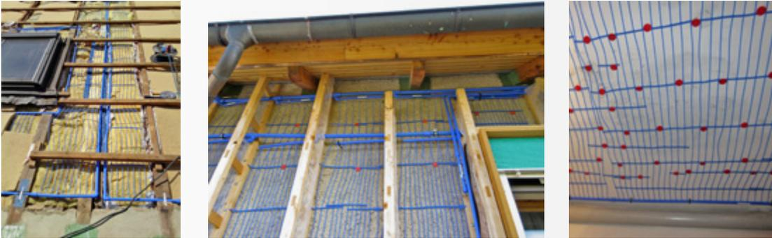
**Bild 3:** Umsetzung einer Kapillarrohrmatten-Umfangsheizung bei der energetischen Ertüchtigung eines Einfamilienhauses. v.l.n.r.: im Dach, an der Außenwand, an der Kellerdecke – jeweils vor Anbringung der Wärmedämmung. (Quelle: A. Lucke / Thermo Integral)
