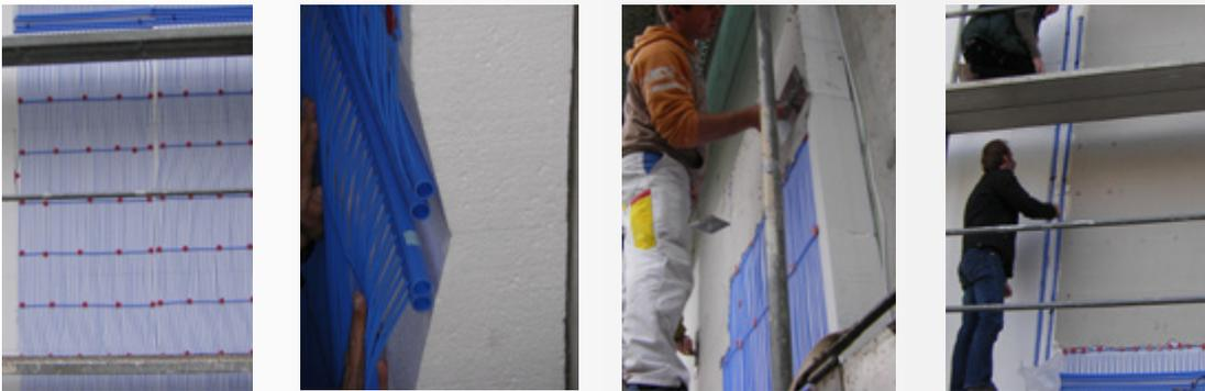
**Bild 1:** Herstellen eines Kapillarrohrmatten-Absorbers im Außenputz der Wärmedämmung [7] v.l.n.r.: Fixierung der Kapillarrohrmatten auf der Polystyrol-Dämmschicht, Integration der Stammrohre, Spachteln des Absorbers, Anbindung der Versorgungsleitungen. (Quelle: A. Born / Sova)
